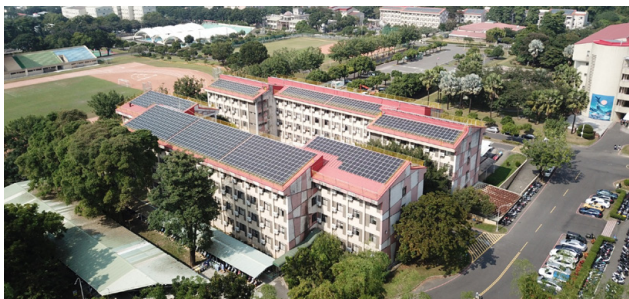
■ 宿舍屋頂設置太陽能發電設備
