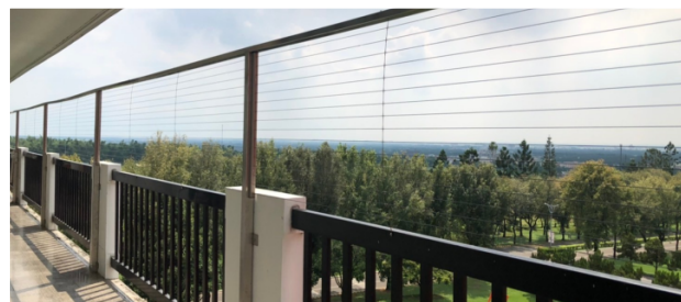
▲ 於高樓層增設安全防墜設施
