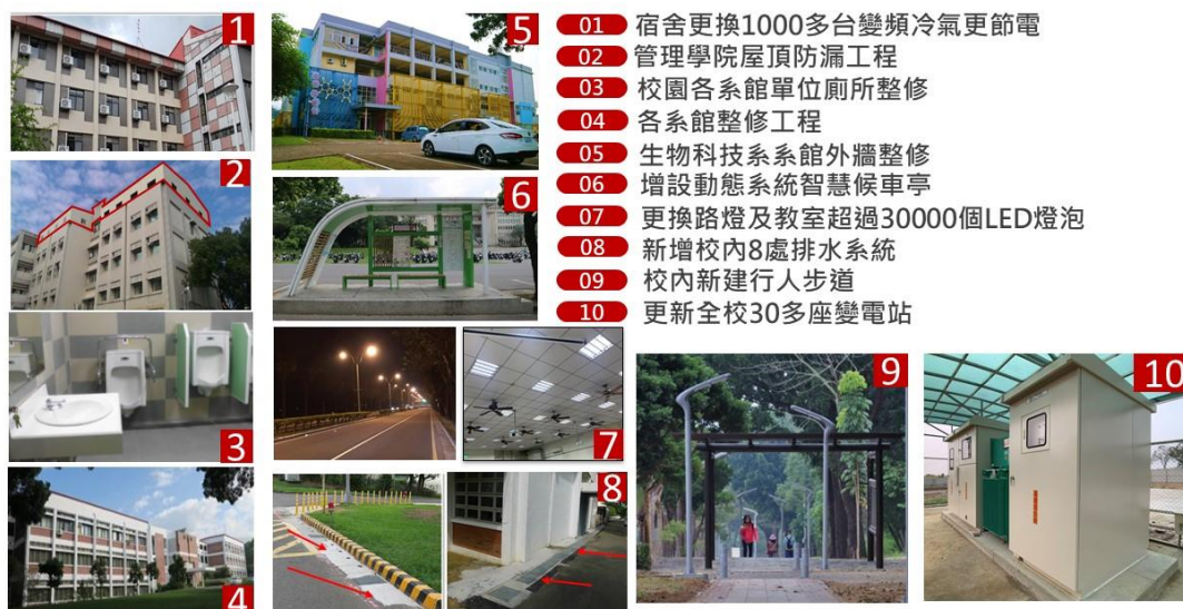
圖 3-3 整修教室、系館、宿舍、運動場地及新建特色教學研發建築
