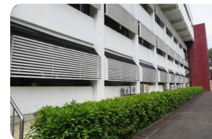
安裝遮陽設施
